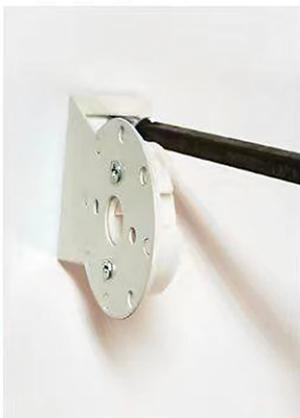
**3** Instala y fija la cabeza con un destornillador. (Nota: Selecciona el exterior o interior correcto según la escena específica del cliente)
