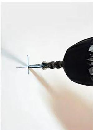
**2** Utilice un taladro percutor para perforar agujeros en la posición de instalación e inserte la expansión en los agujeros
