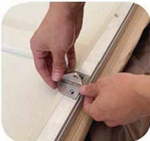
1. Alinee el conector de la escalera con los orificios para tornillos de la bancada.
