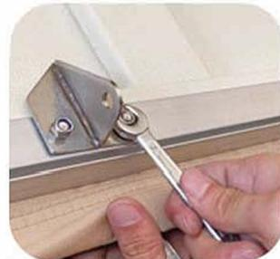
2. El tornillo largo pasa por el orificio del tornillo situado debajo de la bancada y apriete bien las tuercas.
