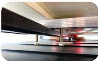
5) Coloque el plástico negro en el centro de la rejilla y la fijación en forma de U y haga que los pernos con deslizamiento se fijen en la placa de fijación en forma de U. A continuación, apriete la tuerca autoblocante de plástico con las manos. Por favor, tenga en cuenta el total de 4 placas de fijación en forma de U que deben fijarse en 4 lados respectivamente
