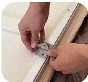
1. Alinhe o conector da escada com os orifícios dos parafusos na placa da cama.
