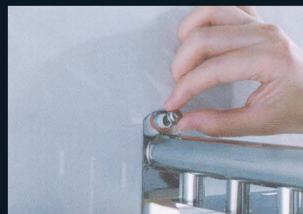
6. Instale el tapón de rosca y complete la instalación.
