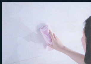
1. Limpie primero el polvo y la humedad de la baldosa cerámica
