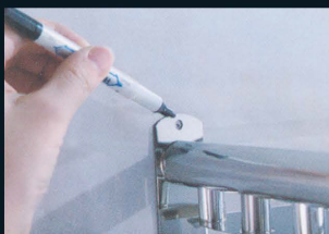
2. Fijar y marcar la posición a instalar
